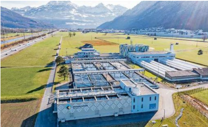
Kostete rund 2 Millionen Franken: Die neu gebaute Anlage (am unteren Bildrand) für die sogenannte vierte Reinigungsstufe.
