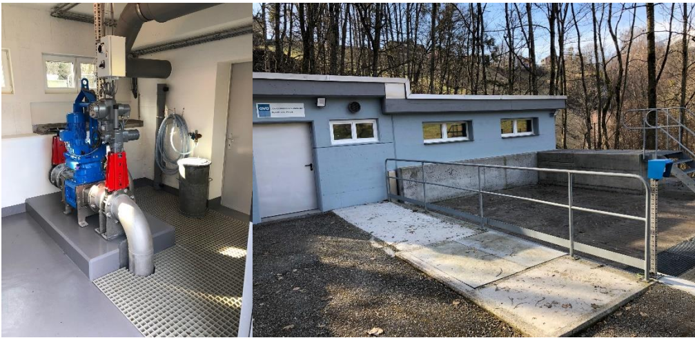
RKB Filzbach nach der Sanierung mit neuem Zerkleinerer und aufgehobenem Sandfang
