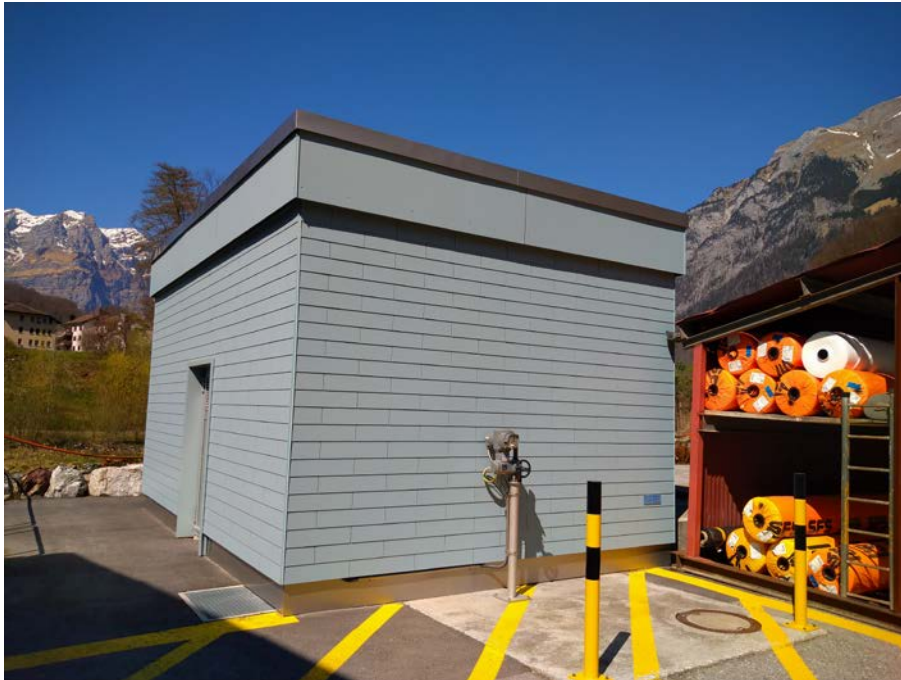
Ansicht Pumpstation Mitlödi nach der Sanierung
