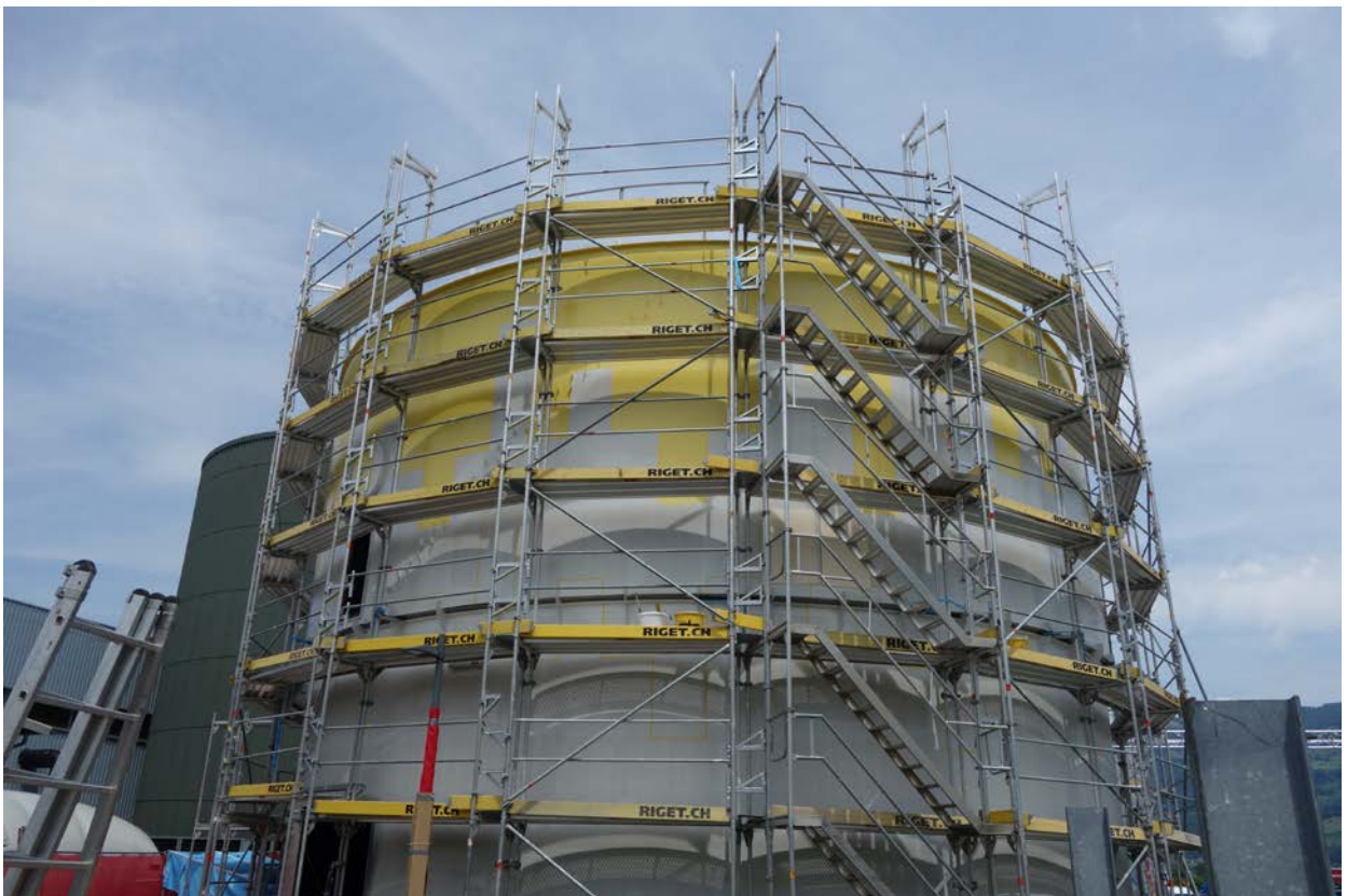
Sanierung Gasometer im Juli 2019
