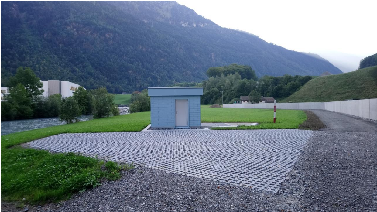
Dükeroberhaupt auf der Südseite der Linth
