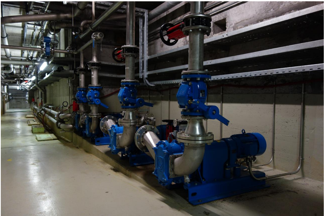
Die neuen Schlammumpen im Rohrleitungskanal Vorklärung
