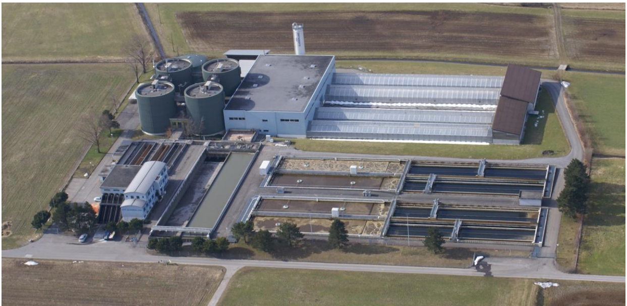
Abwasserreinigungsanlage im Frühjahr
