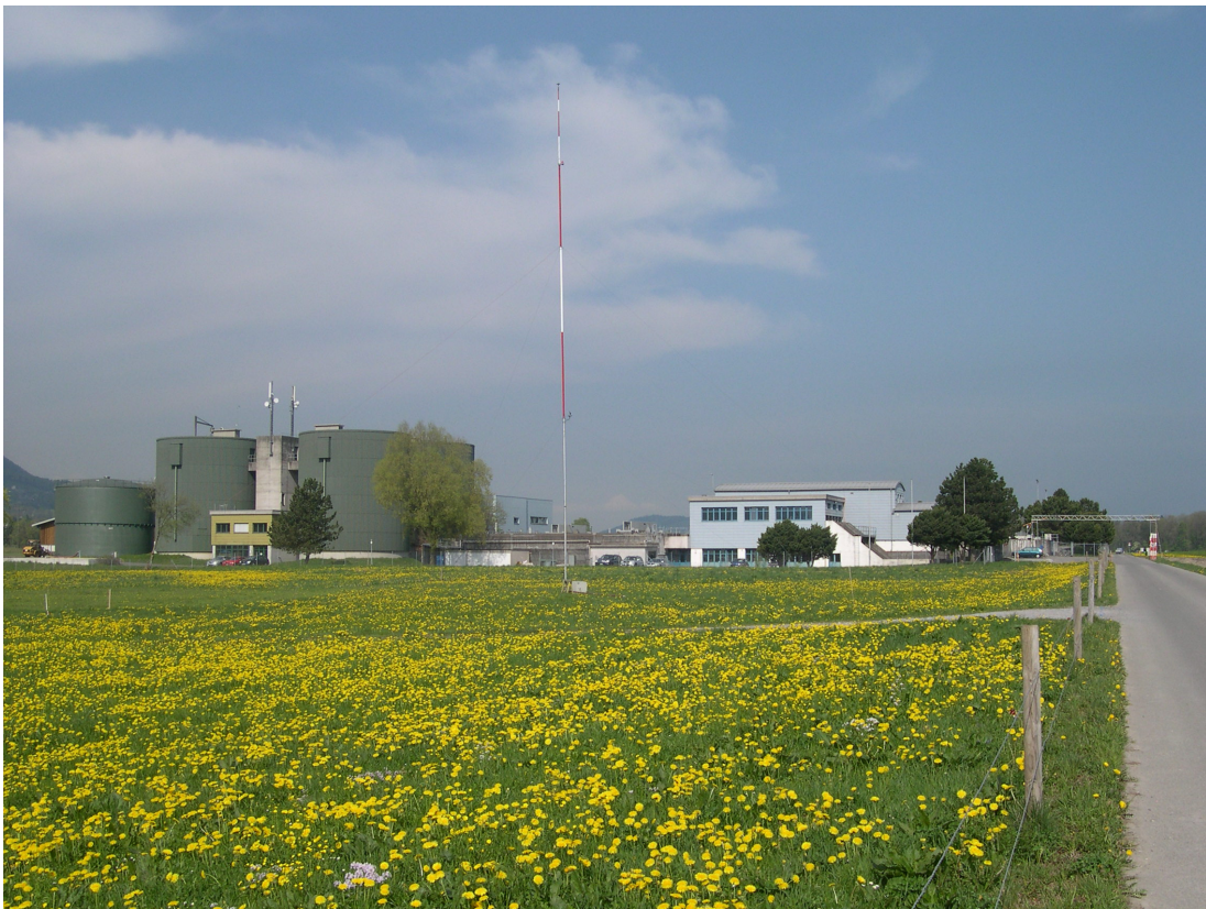
Abwasserreinigungsanlage im Frühling
