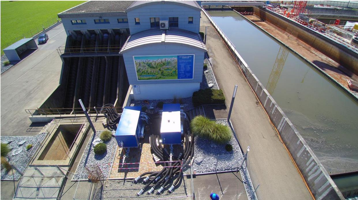
Zwei Drehkolbenpumpen auf Anhänger mit Schallschutzhaube
