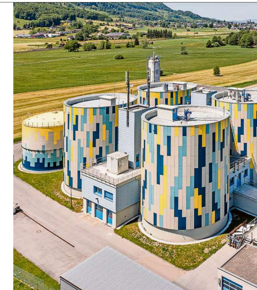
Nicht nur farbenfroh: Durch die Erneuerung der Faultürme entweicht weniger Methangas in die Atmosphäre.
