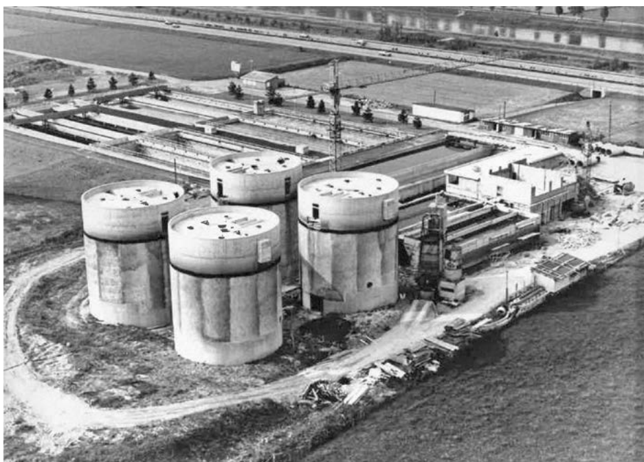
Die ARA 1978 im Bau.
