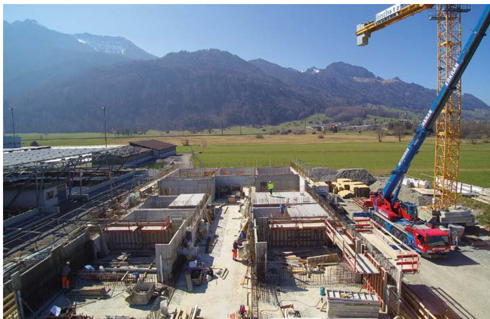
Das neue Gebäude der Anlage zur Elimination von Mikroverunreinigungen ist im Bau.
