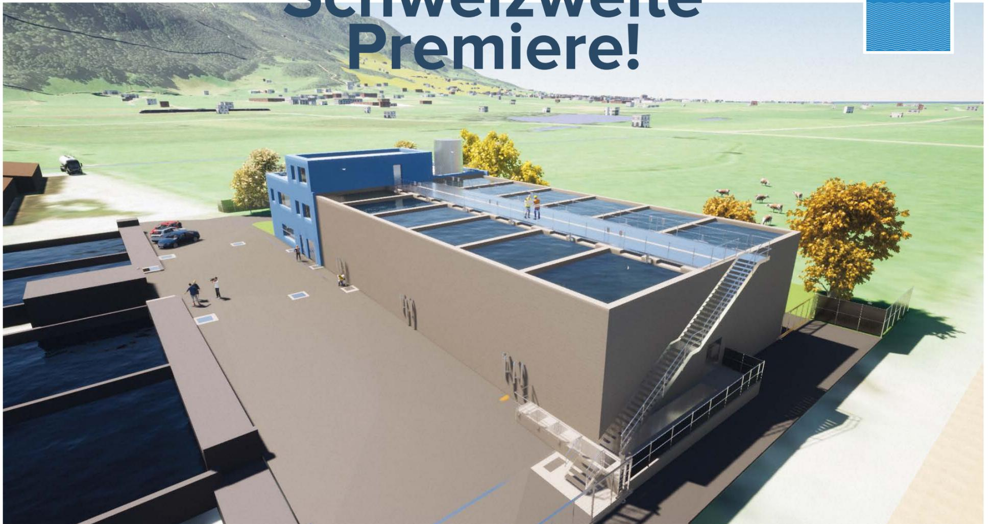
So wird sie aussehen: Die 21 Meter breite und 50 Meter lange Anlage zur Elimination von Mikroverunreinigungen. Sie wird auf der angrenzenden Wiese unserer Kläranlage realisiert. Der Baustart für die Anlage erfolgte Ende April
