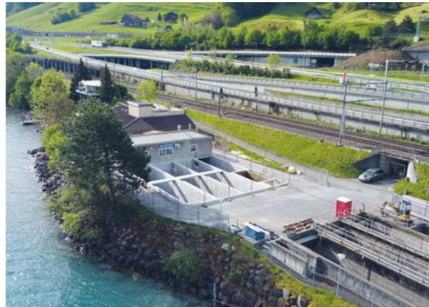
Die ehemalige Kläranlage Mittensee im Umbau. Auf dem Gelände wurde unter anderem ein neues Pumpwerk installiert, welches das Abwasser durch die Leitung in Richtung ARA Glarnerland befördert.
