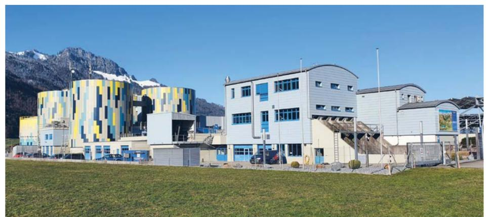
Die Sanierung der Schlammbehandlung ist abgeschlossen. Nun stehen alle drei Faultürme/Schlammstapel/Gasspeicher betriebsbereit und farbenfroh vor Ort. Dank den drei Türmen wird der Ausfaltungsprozess des anfallenden Schlammes optimiert und es kann zirka fünf Prozent
