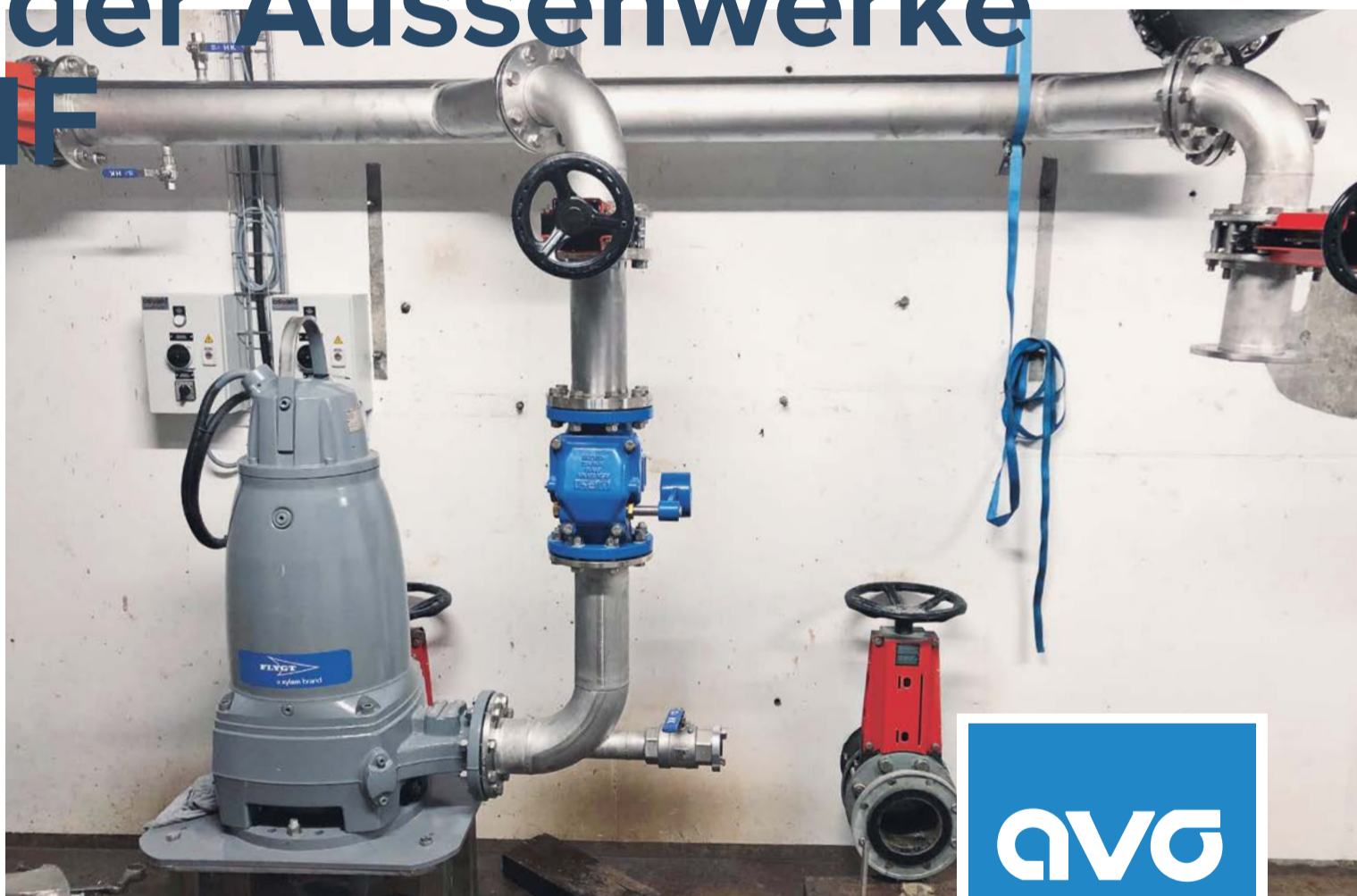
Pumpstation Unterterzen im Umbau. Eine neue Pumpe ist schon in Betrieb.
