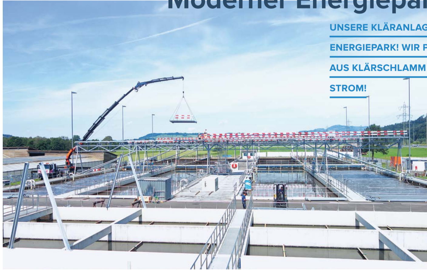
Unser Solarfaltdach über den Biologie-/Nachklärbecken und den Vorklär-/Regenbecken
