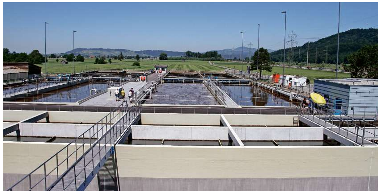
Die Abwasserreinigungsanlage braucht Platz: Viele Besucherinnen und Besucher zeigen sich von der Grösse der Anlage überrascht.
